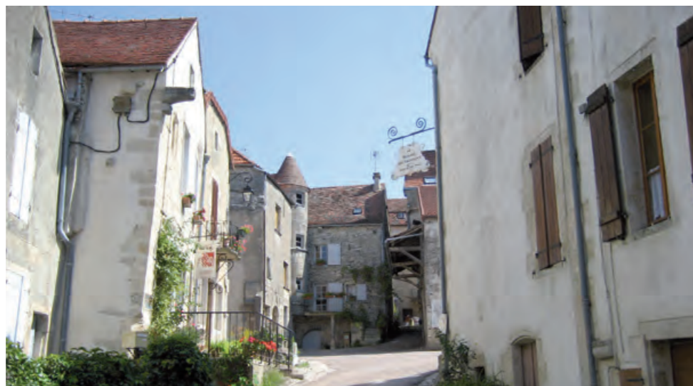
Flavigny, Francja: Kanalizacja podciśnieniowa dla historycznego Starego Miasta z XIII wieku
