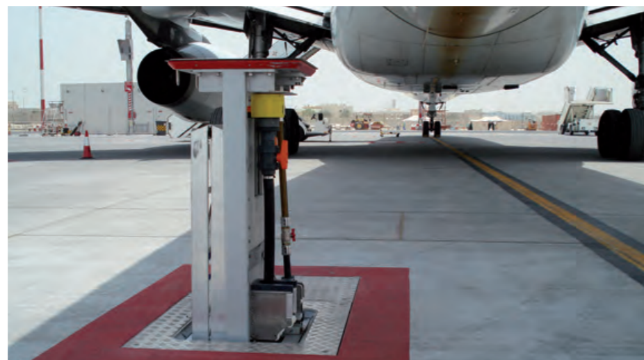
Międzynarodowe lotnisko w Bahrajnie (Fotografia: Cavotec): Kompletny, stacjonarny system zaopatrzenia w wodę i usuwania ścieków
