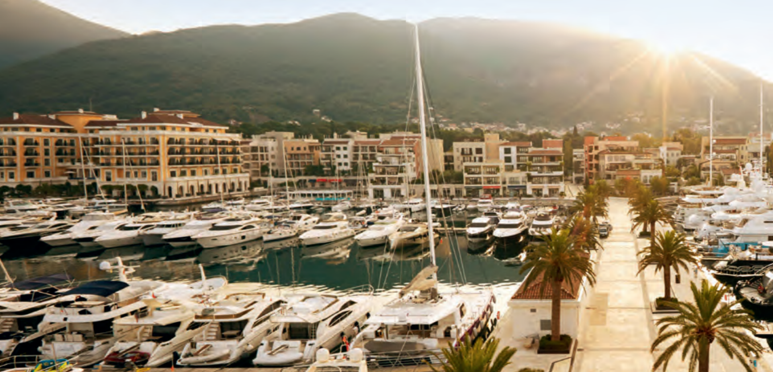
Port Czarnogóra, Czarnogóra: Kompletny system kanalizacji podciśnieniowej dla budynków i jachtów
