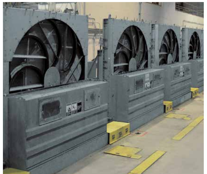
DC Cook Kraftwerk, USA
