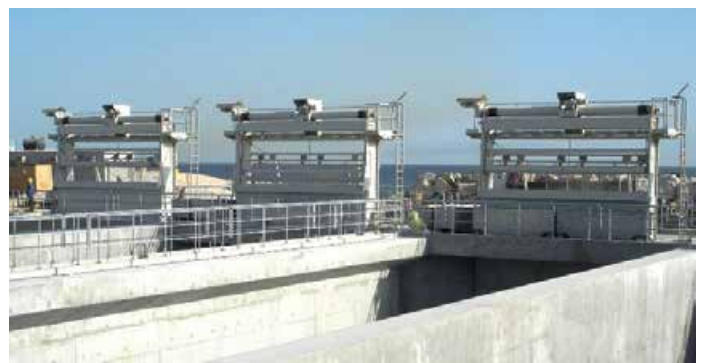
Geiger® seilbetriebene Schalengreiferrechen, stets zuverlässig und vielseitig einsetzbar
