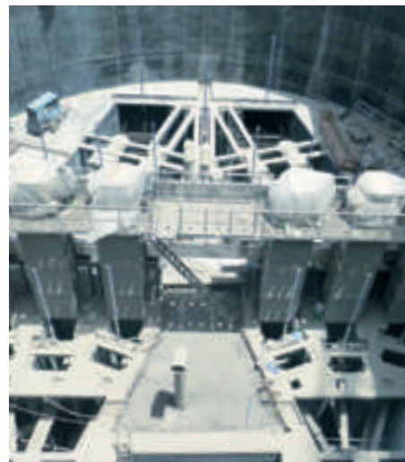
Passavant® Schalengreifer- rechen COB-C Passavant® Rollenschütz (1200 x 3500 mm)
