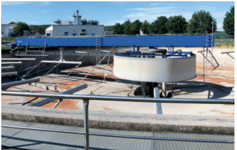
Sanierung von Räumern
