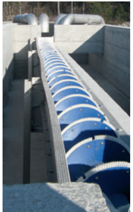
Noggerath® Überlaufsieb OVF für Regenüberlaufbecken
