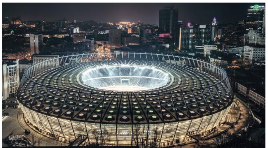
Fußballstadion Kiew, Ukraine: Komplette Abwasser-Entsorgung für 70.000 Personen
