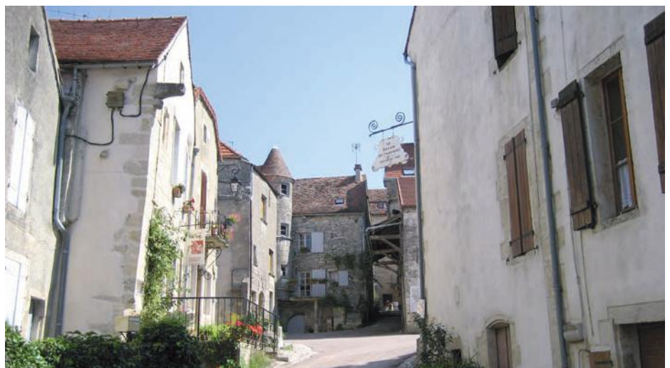
Flavigny, Frankreich: Vakuum-Kanalisation für die historische Altstadt aus dem 13. Jahrhundert
