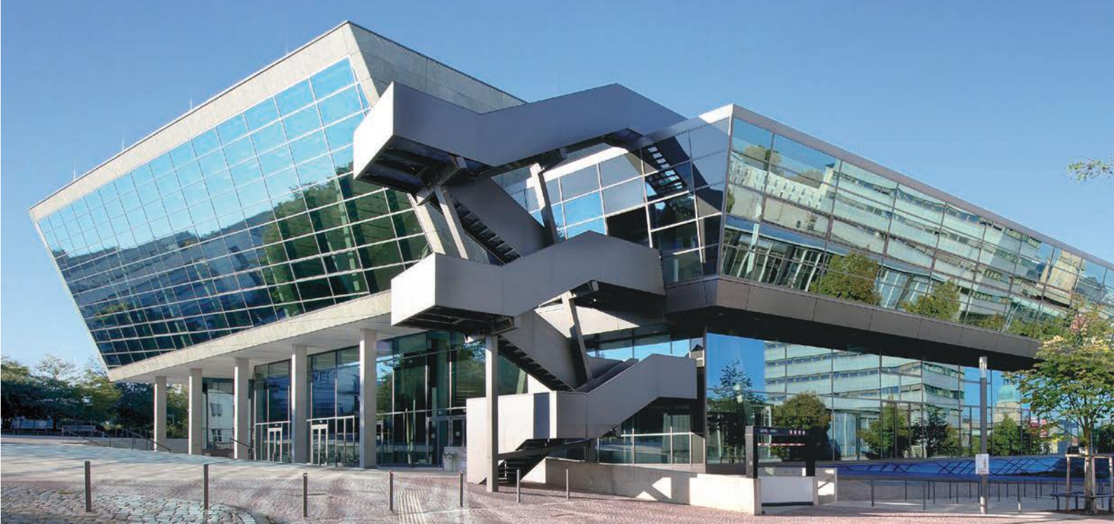
Darmstadtdium, Darmstadt, Deutschland: Fünf Vakuumstationen, komplettes Abwasser-Trennsystem
